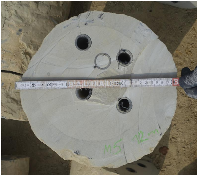
Sonde 5: Bohrdurchmesser 219/190 mm. Der Durchmesser wächst in diesem Beispiel auf zum Teil über 30 cm an.
